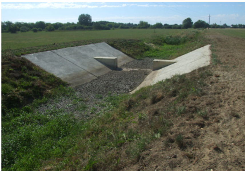
A nyírségi vízhálózat egyik fontos elemének, a Kállai-főfolyásnak a kiszáradt és elgyomosodott medre, a víz visszaduzzasztására létesült, de mostanában jórészt szárazon árválkodó műtárggyal.
