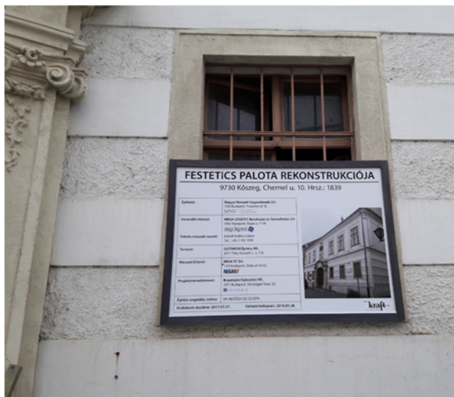
1. kép. A kőszegi Festetics palota építési táblája – fotó: Fejérdy T.
